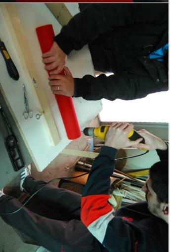
perforación del tubo para el paso del cable de acero inox.
