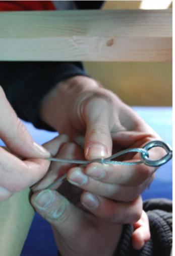
atado de la cortina a la estructura auxiliar de madera
